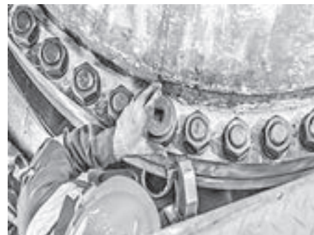
شکل ۲: استفاده از آنتی سیز کمپوند در پیچ های فلنج
