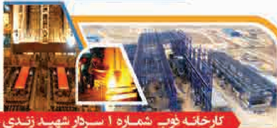
کارخانه در حال ساخت:
