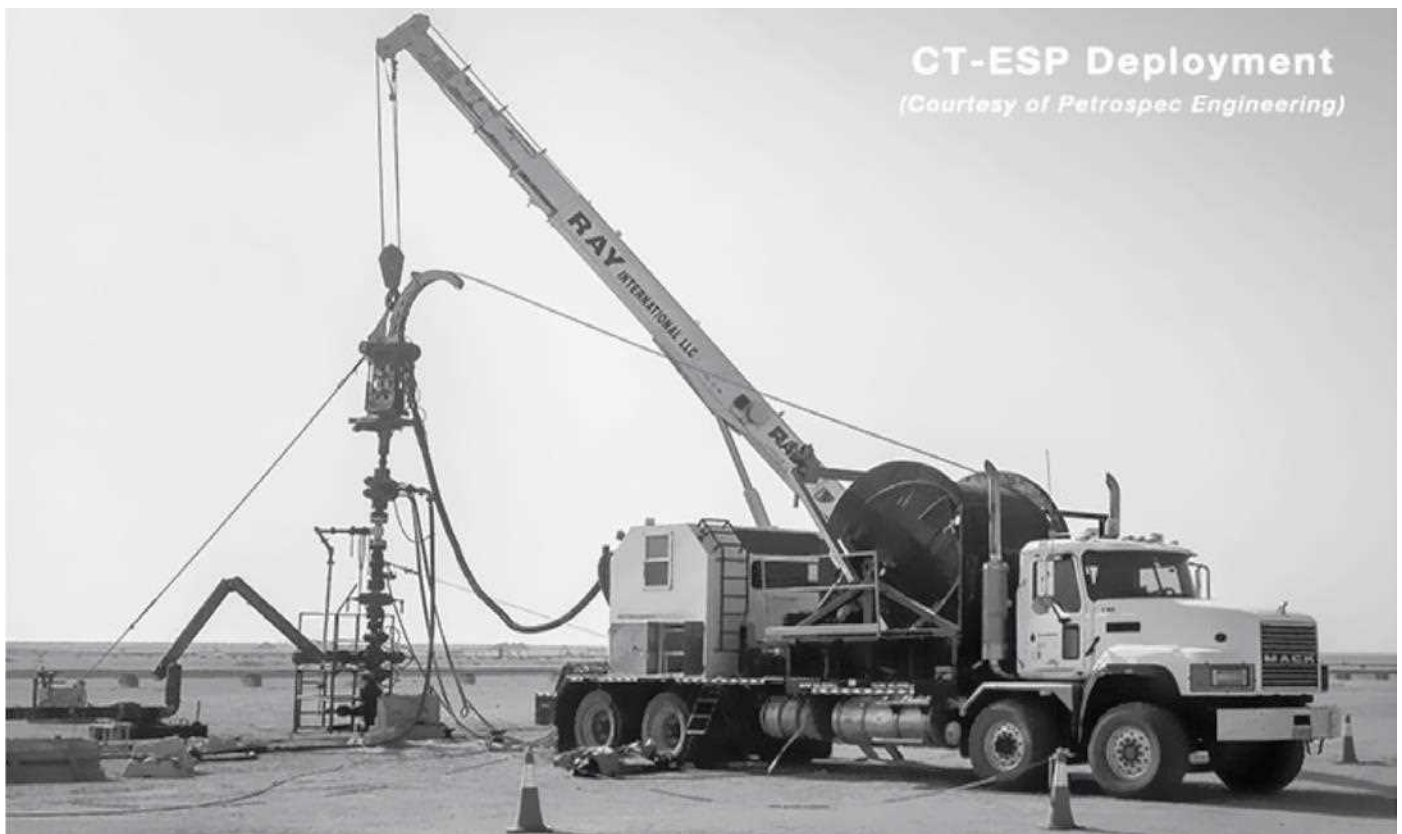
شکل ۱ عملیات ESP بدون دکل در خشکی
