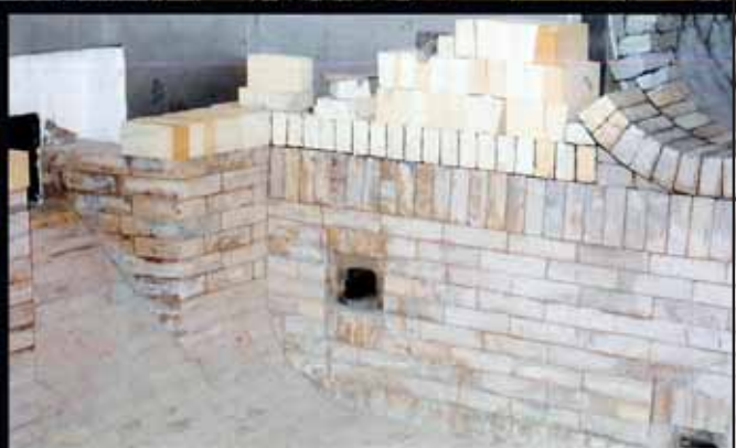
اجرای تسوزکاری کوره ذوب آلومینیوم ۲۰ تن شرکت سیمکات در سال ۱۳۷۴ که در سال ۱۳۹۲ پس از ۱۷ سال کار مداوم مجدداً تسوزکاری گردید که چنین راندمانی در ایران و جهان کم سابقه است
