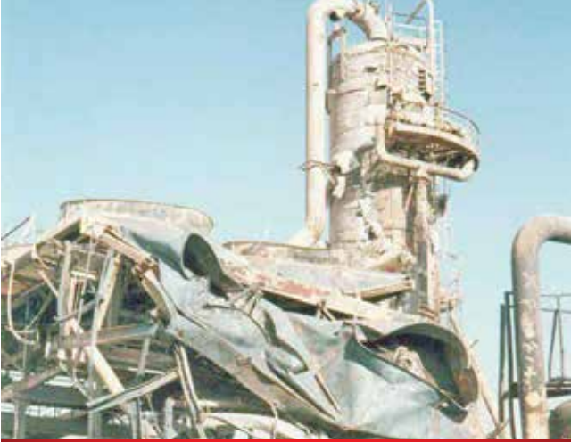
تخریب تأسیسات هوایی پالایشگاه بید بلند در اثر بمباران‌ها
