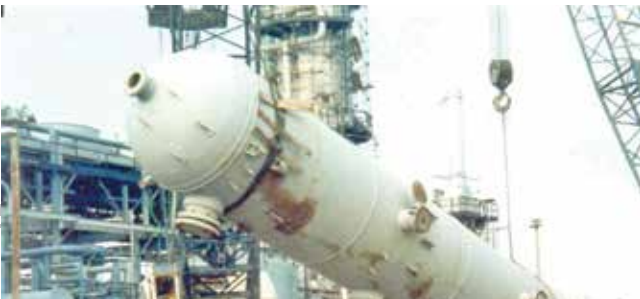
عملیات مرمت برج نم زدایی پالایشگاه گاز بیدبلند، پس از جنگ تحمیلی، مایه شگفتی پیشکسوتان فنی پالایشگاه‌های کشور شد و به عنوان یکی از برجسته ترین اقدام‌ها در زمینه بازسازی تأسیسات نفتی، مورد تقدیر قرار گرفت.
