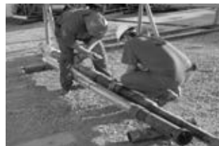
شکل 7- کالیبره کردن ابزار نصب کننده و تویک جهت راندن در چاه
