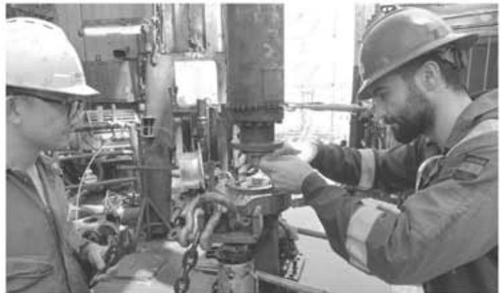
شکل ۱۲. تصاویری از عملیات نصب و راه اندازی مجموعه ESP توسط پرسنل شرکت پادیاپ تجهیز
